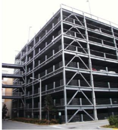
شکل 1-2 نمای خارجی پارکینگ با استفاده از تیر سلولی
