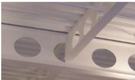
شکل 2-11 پر کردن باز شو تیر سلولی برای نصب تیر فرعی
